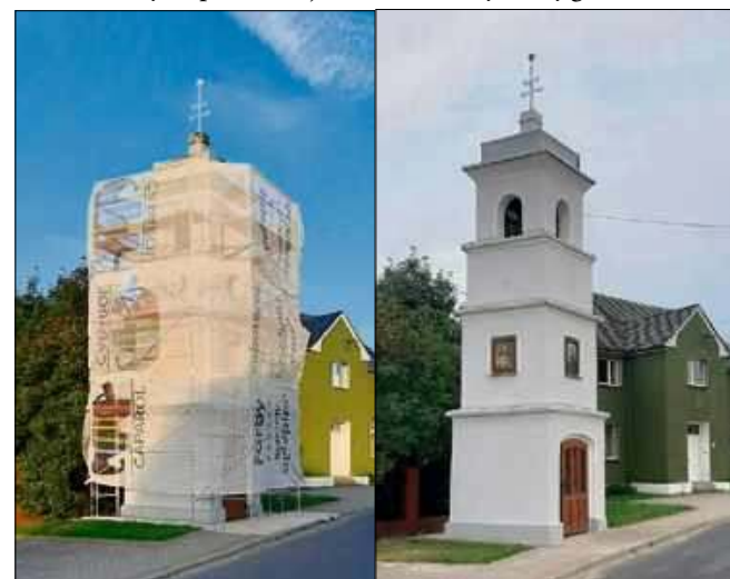
Kapliczka w trakcie remontu i już po jego zakończeniu.
