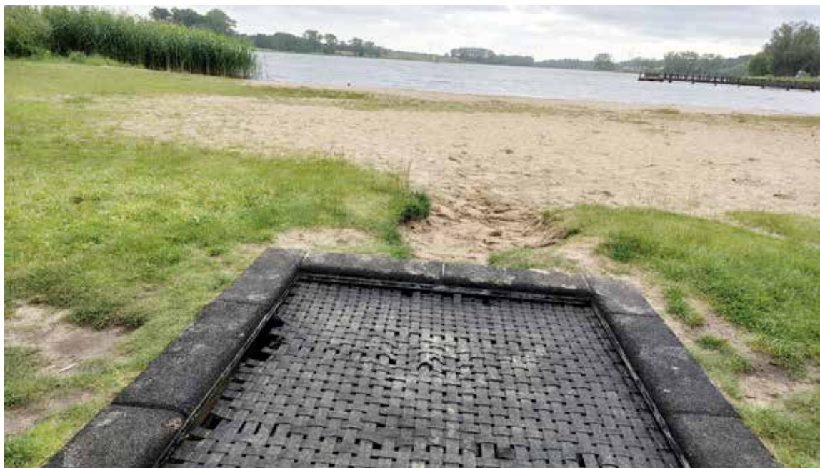
Widoczne uszkodzenia przy trampolinie
