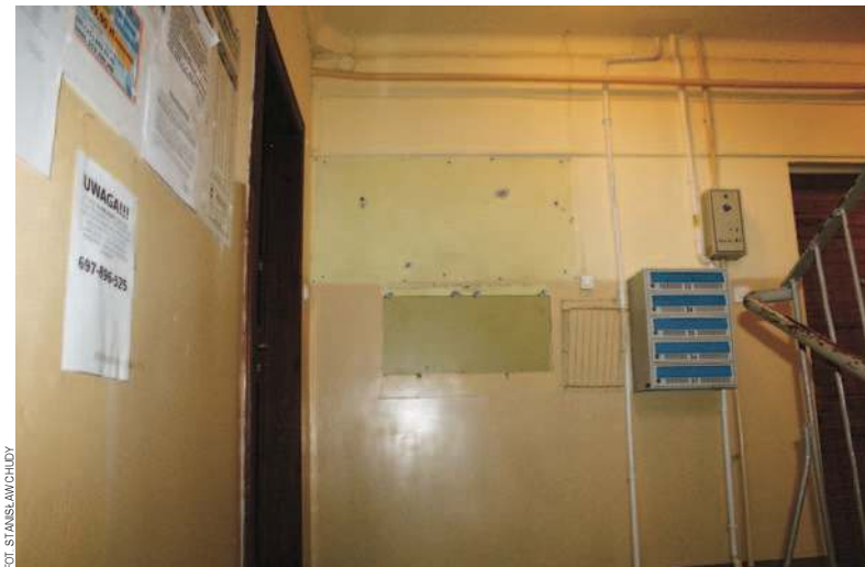
W wieżowcach przy ul. Okulickiego, prace przygotowawcze do doprowadzenia pionów instalacji c.c.w. polegały m.in. na... przeniesieniu w inne miejsce części skrzynek pocztowych. Bo właśnie tam, gdzie się do tej pory znajdowały, poprowadzona zostanie główna instalacja c.c.w.
