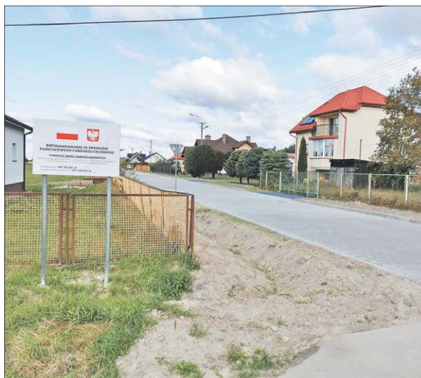
Wiosną bieżącego roku zakończono projekt pn. „Budowa i przebudowa dróg w miejscowości Sławatycze”
