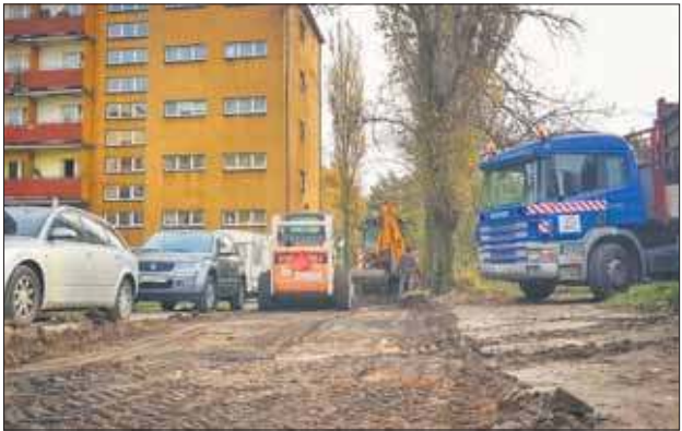
Trwa już przebudowa drogi
