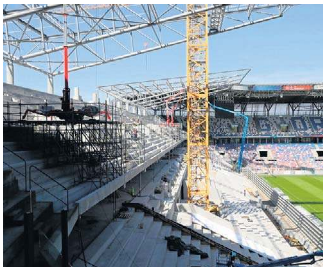
Nad czwartą trybuną Górnika trwa montaż dachu. Prace mocno już wyprzedziły przewidywany harmonogram
