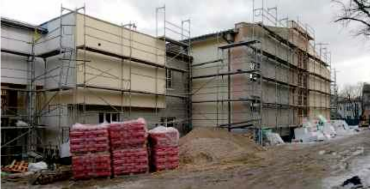
Ostatnio z uwagi na niskie temperatury wstrzymano prace przy elewacjach obiektu, ale cały czas wiele działa się wewnątrz budynku
