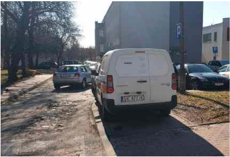
Parking przy przychodni wraz z wjazdem będzie w tym roku przebudowany
