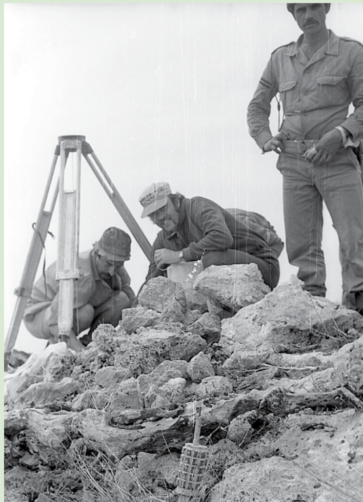
Ustawianie statywu na zaminowanym punkcie pomiarowym - poniżej widoczna mina.
