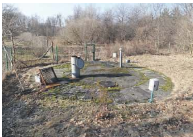
Oczyszczalnia ścieków przed i po modernizacji
