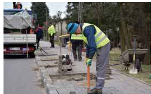
Drzewa zostały usunięte, teraz czas na uzupełnienie chodnika
