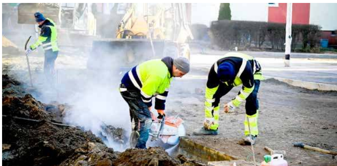
Trwa remont ulicy Chrobrego. Od poniedziałku czekają nas zmiany w organizacji ruchu w związku z kolejnym etapem prac
