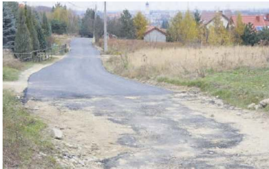
W budżecie gminy Strzelin znalazły się pieniądze na remont odcinka ulicy Sosnowej, który łączy Strzelin z Gęsińcem. Fot. archiwum Słowa
