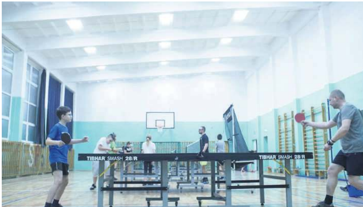
W sali gimnastycznej SP nr 5 zamontowano 24 nowoczesne lampy. Foto: UMiG Strzelin
