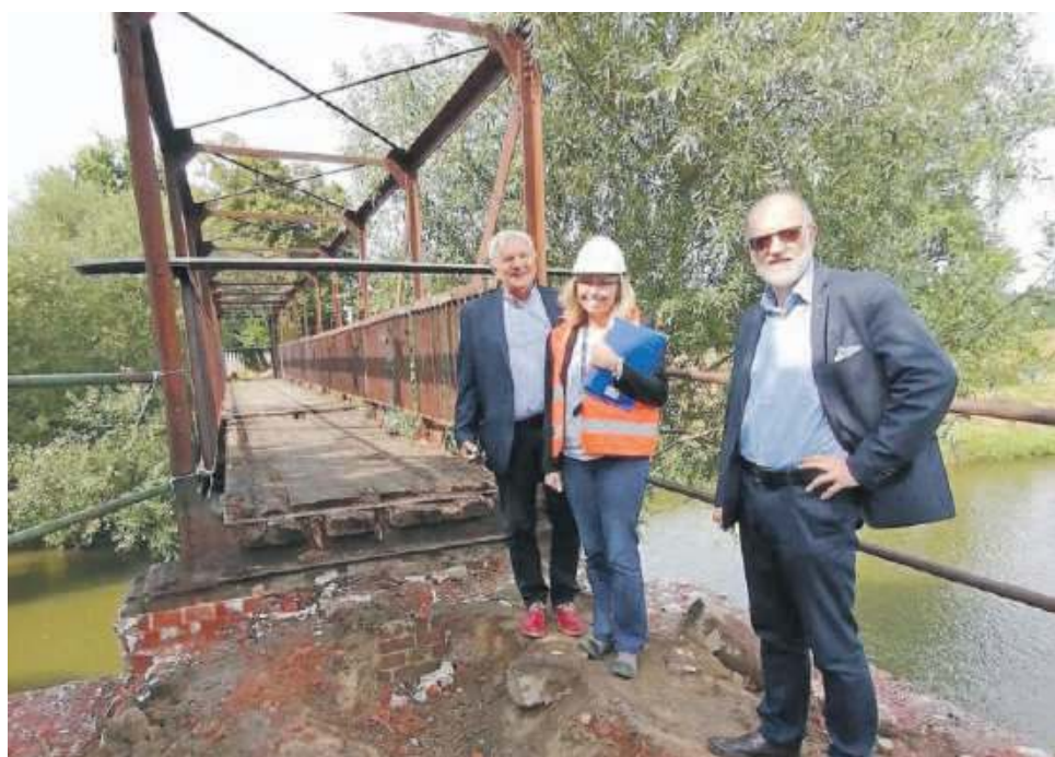
Kładkę, która doczeka się renowacji odwiedzili: starosta oławski i pracownicy PZD w Oławie
