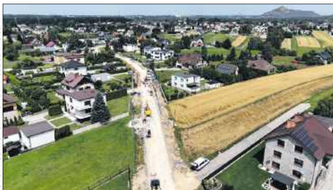
■ Nowa droga, chodniki, odwodnienie i oświetlenie. Trwają prace na jednej z ważniejszych ulic Radlina.
