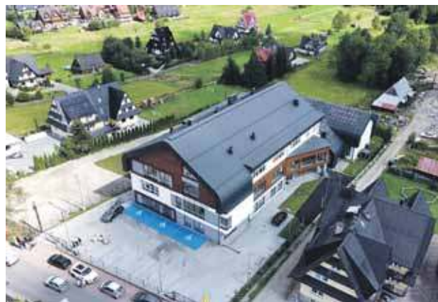
Jeszcze trwają ostatnie prace porządkowe, ale szkoła w Murzasichlu już wygląda imponująco.
