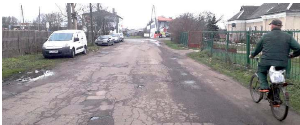
Ulica Objazdowa wymaga solidnego remontu
