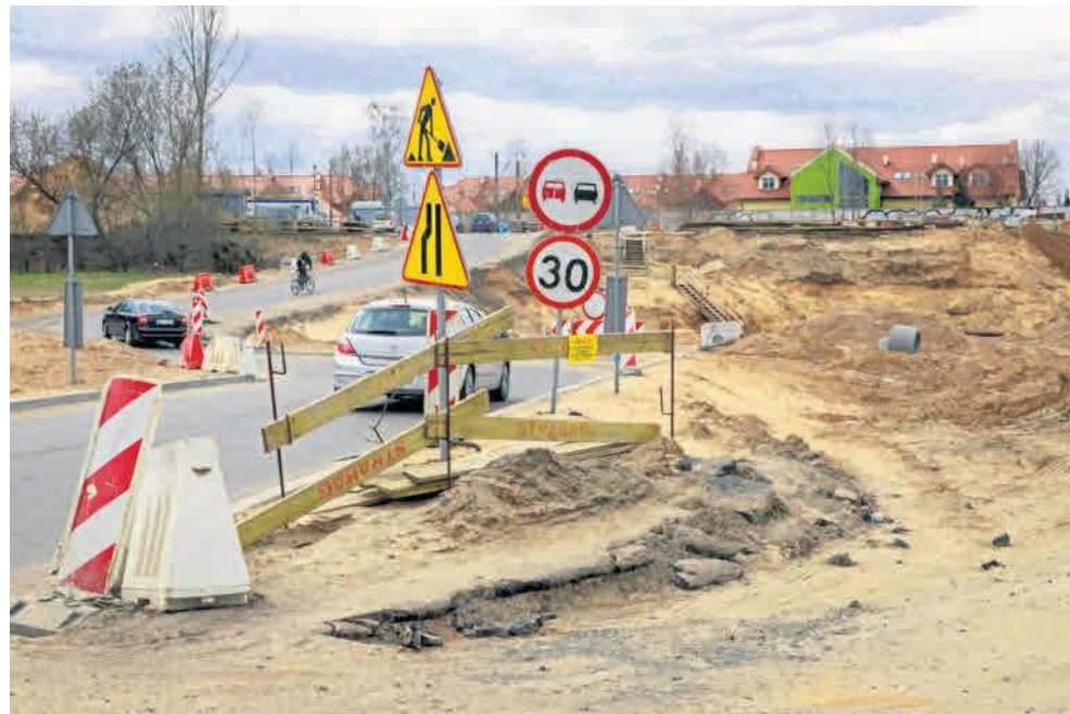
Przerwane na początku lutego prace na Klepackiej, do tej pory nie zostały wznowione
