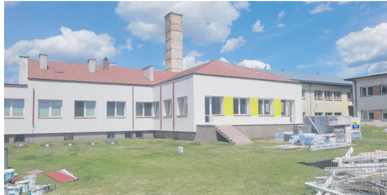
Szkola w trakcie remontu
