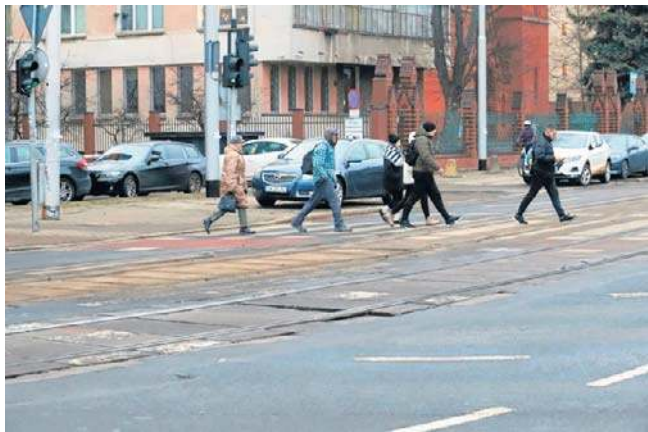
Wymienione zostaną szyny oraz nawierzchnia torowiska. Płyty poprawią stabilność toru
