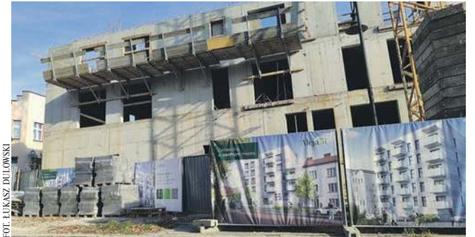
Budowa obiektu wielorodzinnego przy alei Henryka w Chrzanowie
