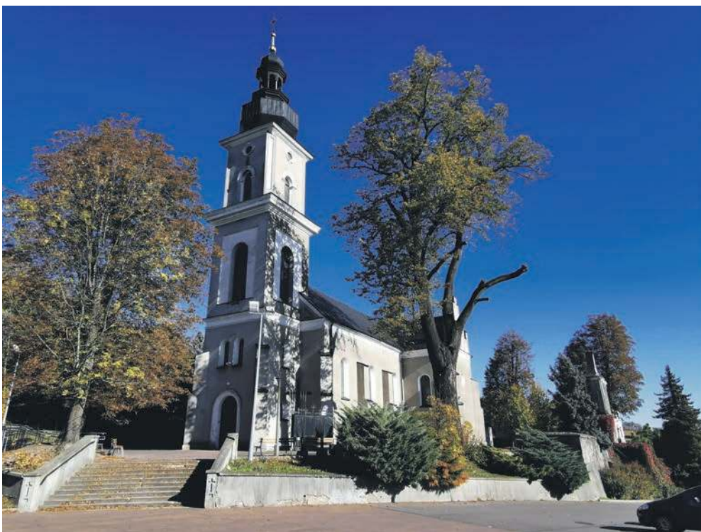
Podczas ofensywy wojsk radzieckich, kościół został solidnie podziurawiony. Zniszczona została wieża, na którą Niemcy wciągnęli małe działo
