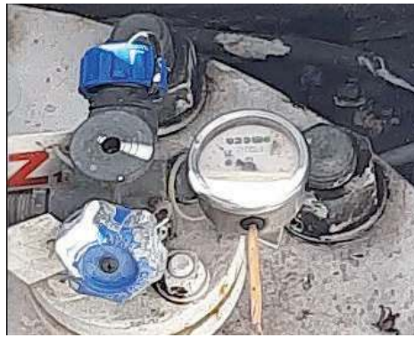
Na szczęście udało się zlikwidować wyciek.
