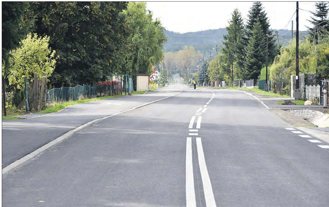
Powiat Prudnicki modernizuje kolejny odcinek swojej szosy między Łąką Prudnicką a Pokrzywną
