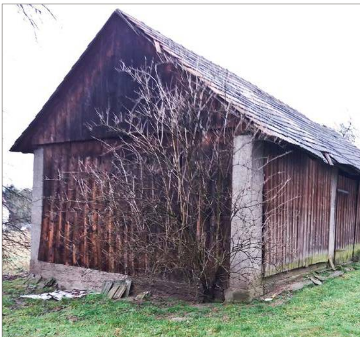
Do wypadku doszło przy rozbiorce stodoły w Niedźwiadzie.
