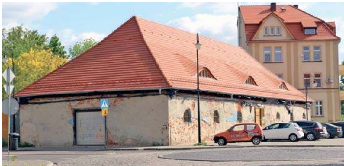
Magazyn solny (fot. UM Nowa Sól)
