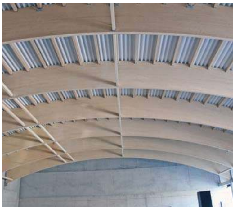
Trwają m.in. prace nad dachem
