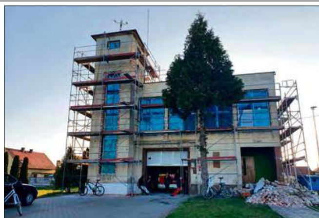
Prace remontowe już się rozpoczęły.
