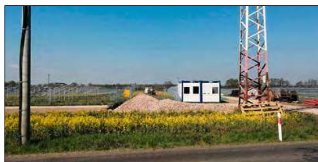
Przedsięwzięcie polega na instalacji ok. 29 988 paneli fotowoltaicznych o mocy 300 watów (Wp) każdy.
