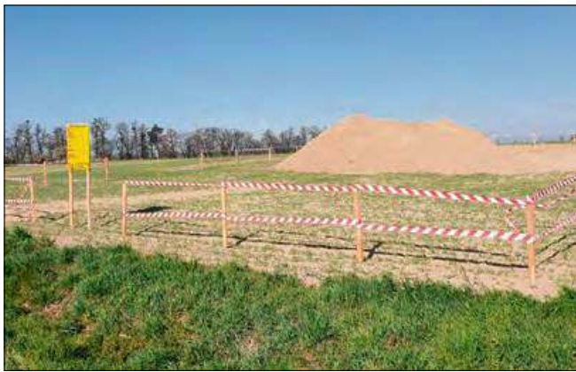
Prace na placu budowy już ruszyły.
