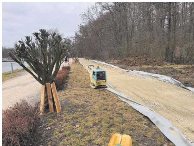
Tak wyglądała budowa podczas rozpoczęcia inwestycji
