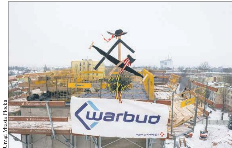
Na budowanym aquaparku przy ulicy Miodowej zawisła wiecha
