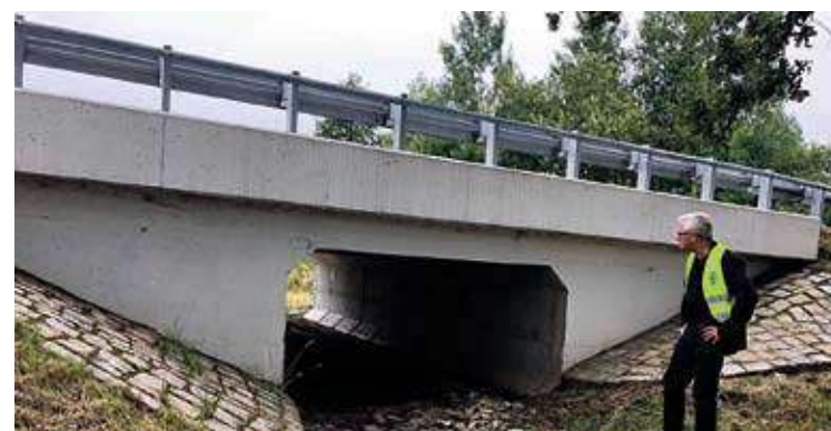
PRZEPUST NA TRASIE SMOGORZÓW WIELKI - WIŃSKO
