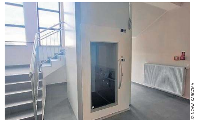
Dzięki inwestycji osoby z problemami z poruszaniem się będą mogły swobodnie korzystać z całego obiektu.
