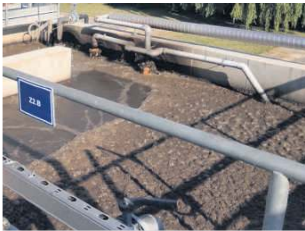
Rozbudowa oczyszczalni ścieków pozwoli zlikwidować nieszczelne szamba
