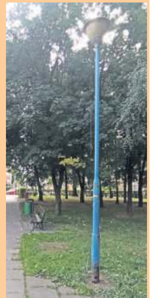
Wykonawcą nowego oświetlenia parkowego będzie firma ZIE Mordko Sp. z o.o. z Mikoszo- wa
