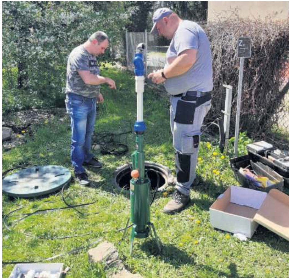
Pracownicy Zakładu Usług Komunalnych wymienili niedawno część pomp. Gmina Kondratowice stara się właśnie o 2 mln zł na dalszą modernizację sieci kanalizacyjnej
