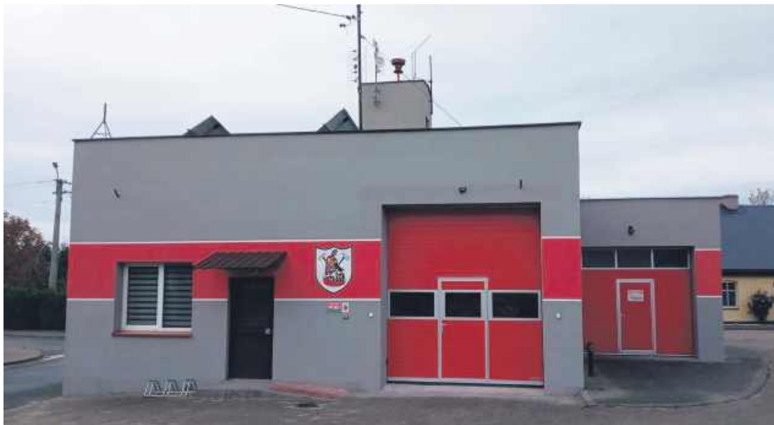
Tak remiza prezentuje się po przebudowie.
