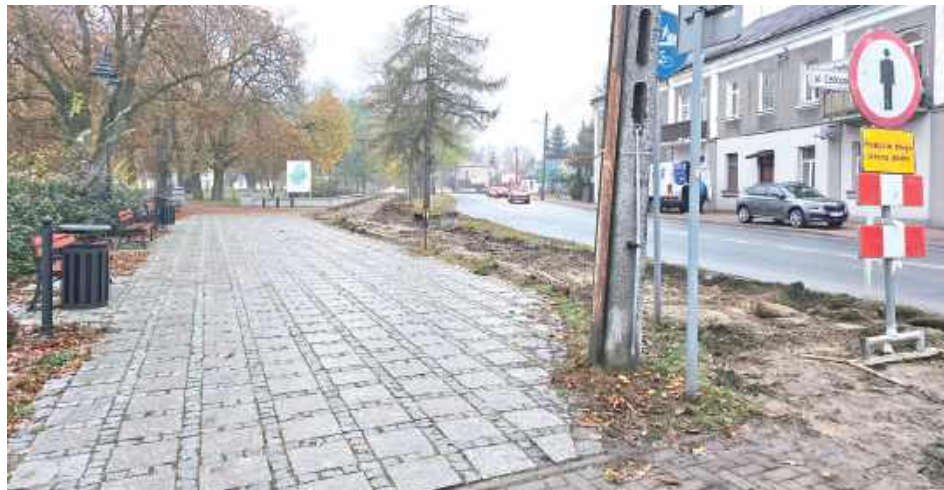
Prace trwają od początku ubiegłego tygodnia
