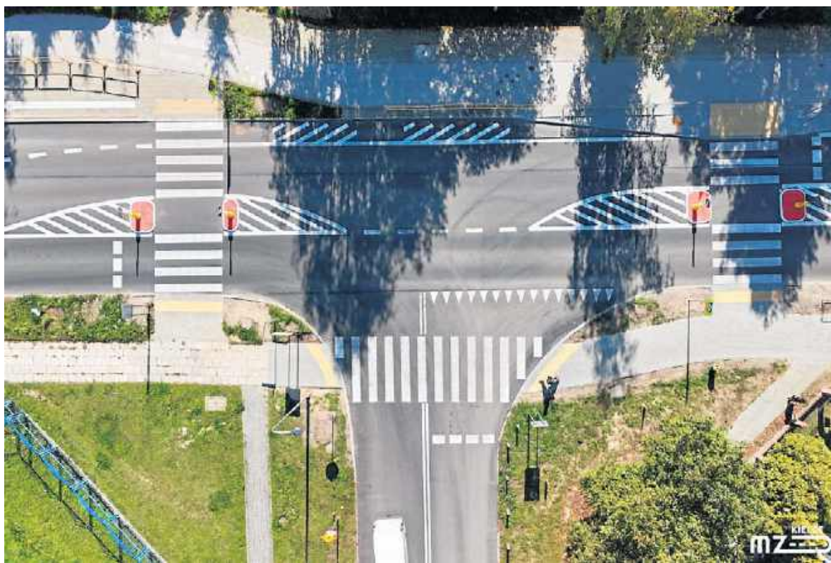
Ulica Wrzosowa zyskała nową nawierzchnię na blisko kilometrowym odcinku
