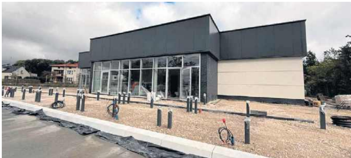
Na finiszu jest układanie krawężników wraz z wykonaniem podbudowy
