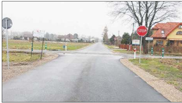
W zeszłym roku została wybudowana ul. Nowa w Drelowie, to droga gminna wykonana od podstaw
