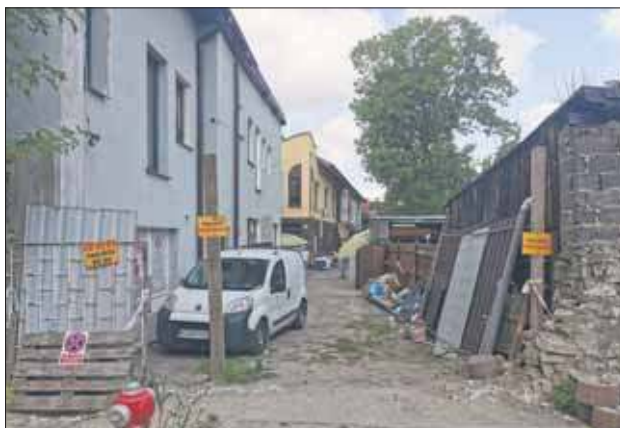
Przejście może pozostać na stałe
