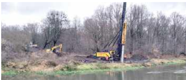
Praca palownicy nad brzegiem rzeki Wieprz
