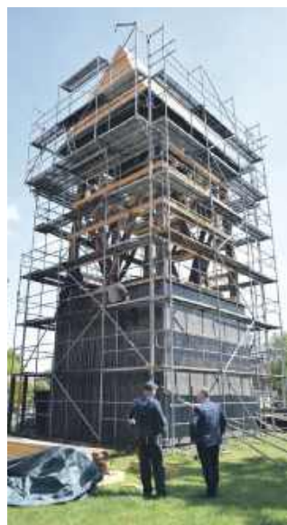
Remont dzwonnicy przy kościele w Strzeszowie
