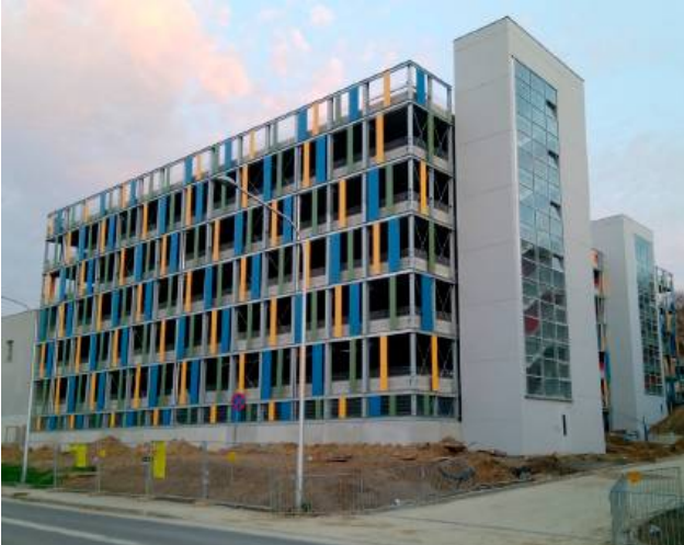
Budowa wielopoziomowego parkingu UM powoli dobiega końca
