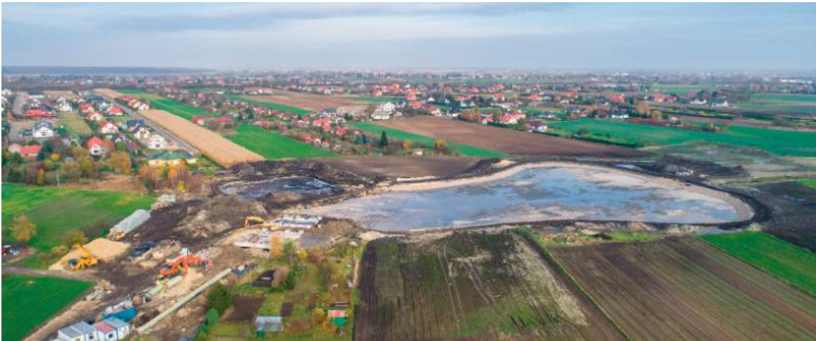
Budowa kolektora deszczowego zwieńczona powstaniem w 2021 roku zbiornika retencyjnego o powierzchni ponad 1,7 ha w dużej mierze rozwiązała problemy Świdnika z podtopieniami po ulewnych deszczach
