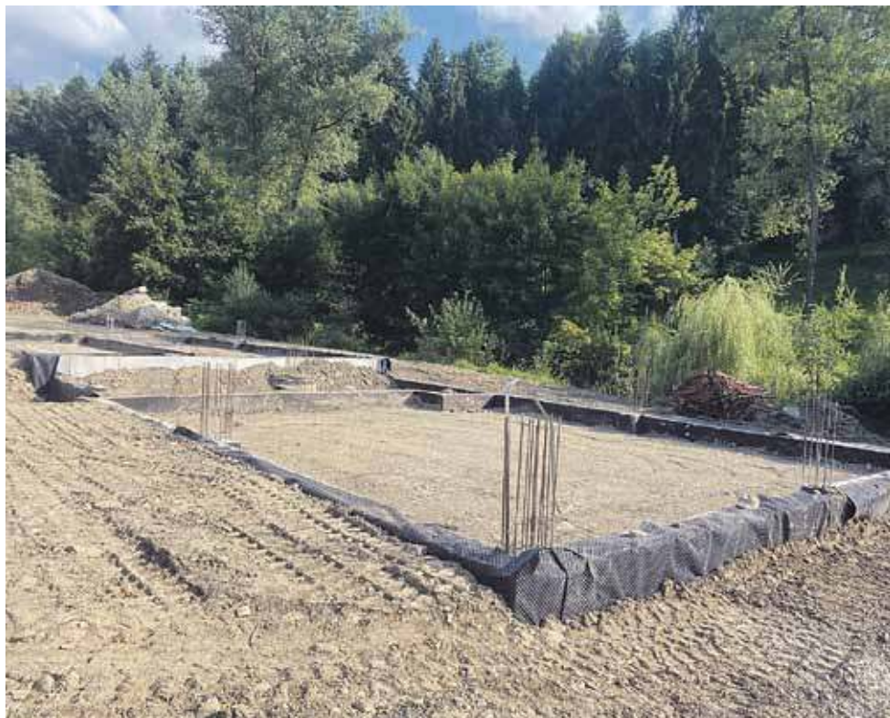
Fundamenty nowej remizy w Ponicach.
