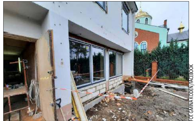
– Prawdopodobnie prace zakończą się w sierpniu, ale w umowie termin jest późniejszy. Prace wykonuje firma z Białej Podlaskiej – przekazuje wójt Jerzy Troć
