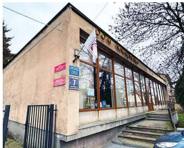
Ratusz chce wyremontować budynek tzw. Domu Nauczyciela
