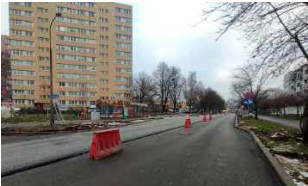
Przebudowa pierwszego odcinka ul. Herberta prawie gotowa. Mieszkańcy i kierowcy mają nadzieję, że w przyszłym roku to samo stanie się z fragmentem od ul. Dunikowskiego do ul. Budowlanej
