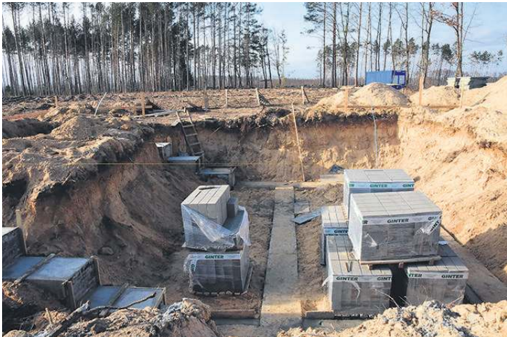
Prace budowlane związane z budową leśniczówki już się rozpoczęły.
