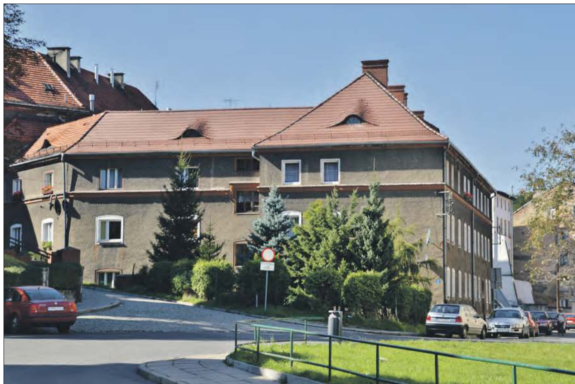
Te budynki zostaną wyremontowane
