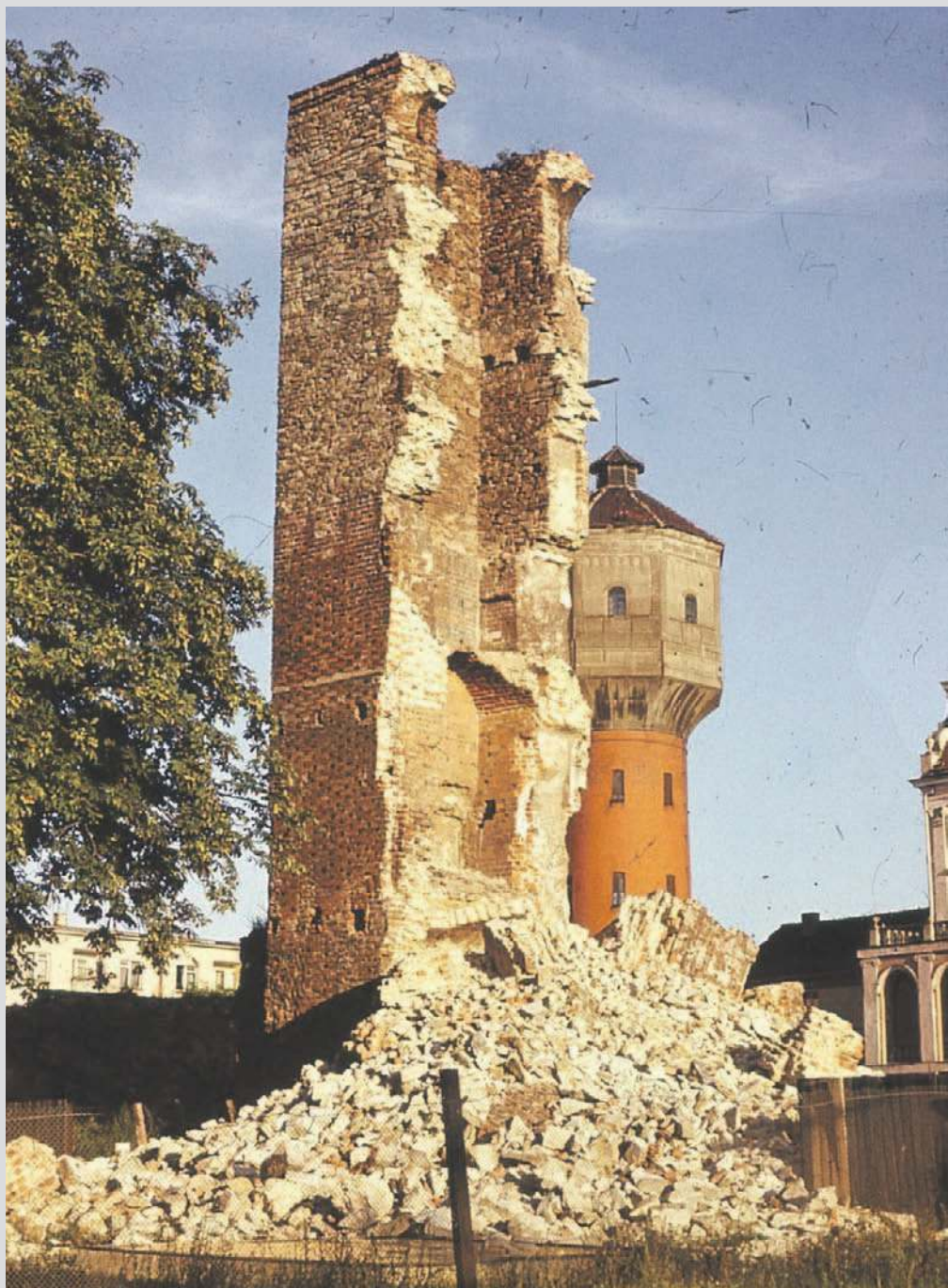
Już po zawaleniu
