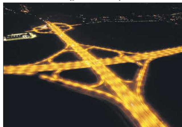
Obwodnica Olsztyna w ciągu S51
