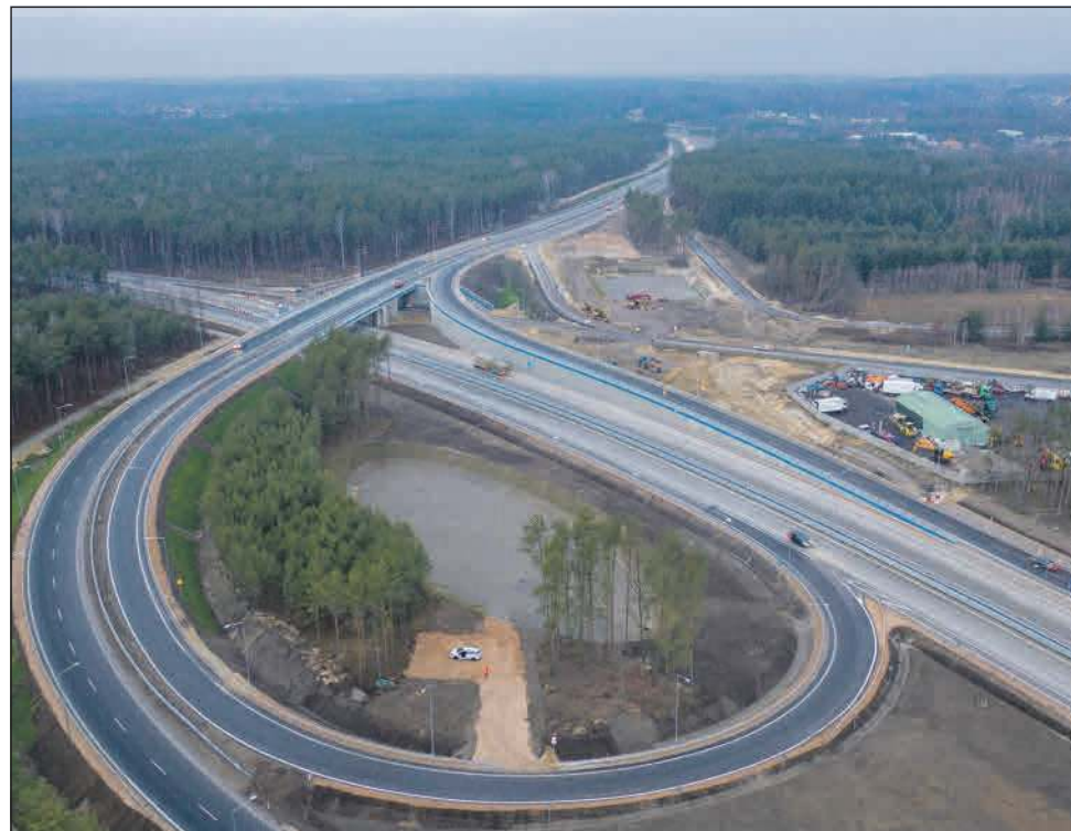
Obwodnica Góry Kalwarii w ciągu DK 50 i DK 79
