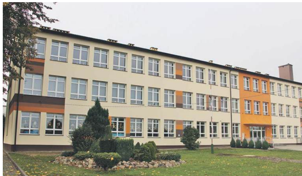
Dzięki przeprowadzonej termomodernizacji szkoła zyskała nowoczesny i estetyczny wygląd.
