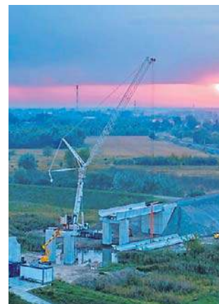
FOT. EXBUD KONSTRUKCJE
