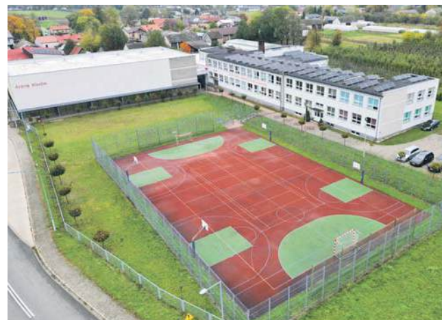
Budynek Zespołu Szkół Samorządowych w Klwowie
