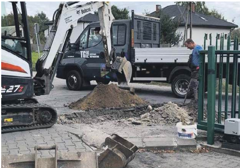
Budowa przyłącza gazowego przy PSP w Przytyku.
