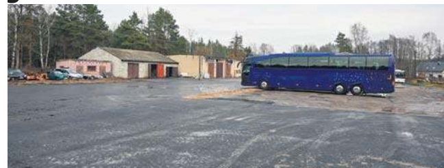
Na terenie Powiatowego Zarządu Dróg Publicznych w Białobrzegach wykonano nową nawierzchnię placu.
