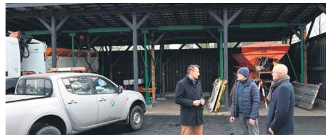
Została wybudowana wiat na sprzęt do zimowego utrzymania dróg.
