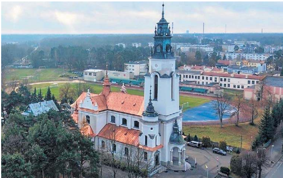
Kościół świętej Barbary w Pionkach jest już po remoncie. Naprawiono poszycie dachowe, więźbę dachową, elewację. Wymieniono okna i drzwi.
