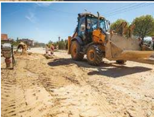
Budowa ulicy Szkolnej
