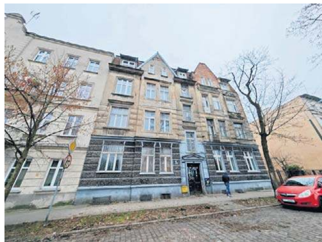
Kamienica przy ul. Słowackiego 67 - tutaj kompleksowy remont niedawno ruszył
